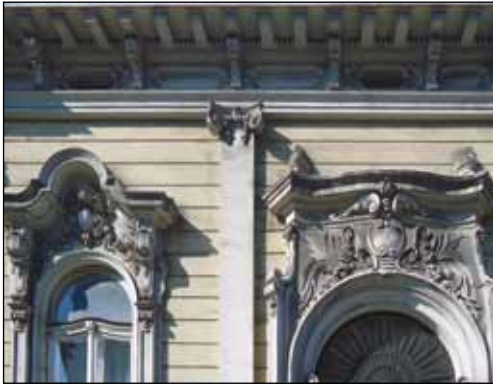
Крсмановићева кућа, звана „Пројокол”, детаљ са фасаде
