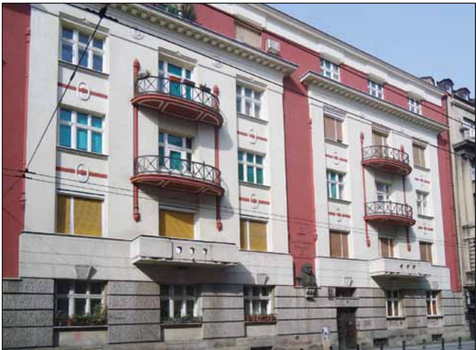
Задужбина Влајка Каленића, Светогорска 12 Зграда је подињена 1935. године, према пројекту грађевинској инжењера Радослава В. Тодоровића
